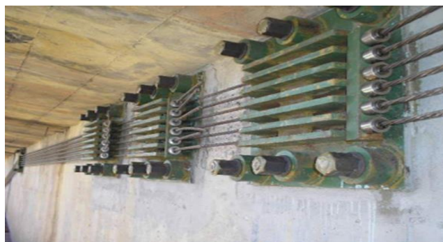
Figura 8 - Reforço com protensão externa
